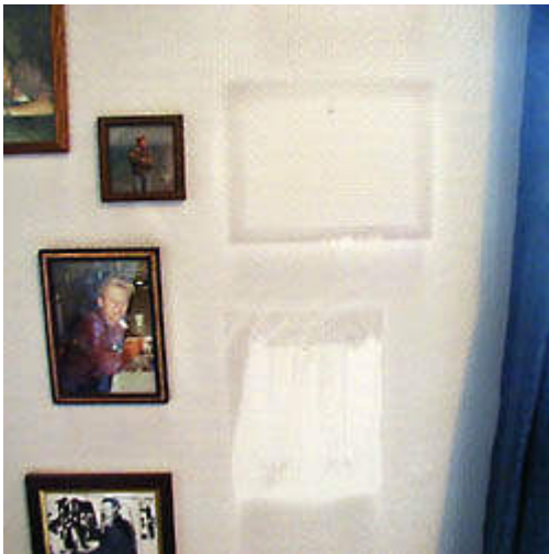
Abb. 7 und 8 Schwarzfärbungen an Wänden mit abgenommenen Bilderrahmen 36
