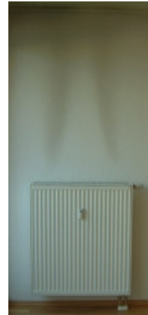
Abb. 3 Schwarzfärbung über einem Heizkörper 8
